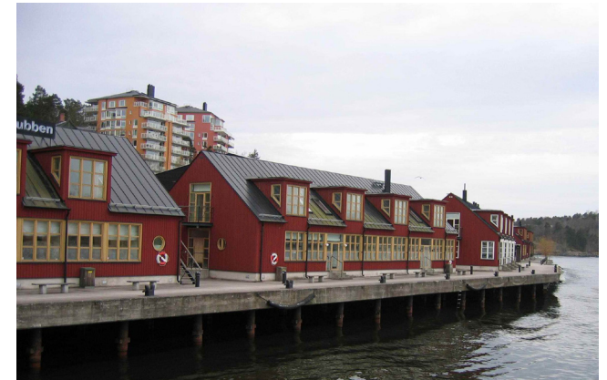
Exempel på byggnader för kontor och verksamheter i Nacka Strand
